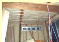
外壁断熱工事の例
