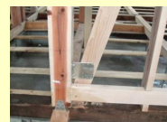
耐震補強工事の例
