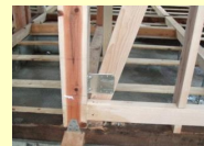
耐震補強工事の例
