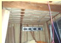
外壁断熱工事の例
