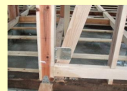
耐震補強工事の例
